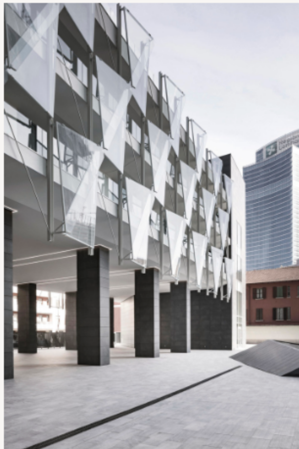
Elemento chiave del progetto è la facciata prismatica con vetrate triangolari composte in vetro, le quali realizzano effetti di luce differenti.
