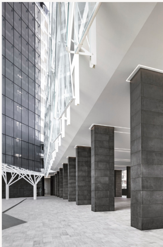
Contrasto tra background chiaro per riflettere la luce e un colore più scuro, utilizzando il sistema di facciata ventilata di Granitech®.
