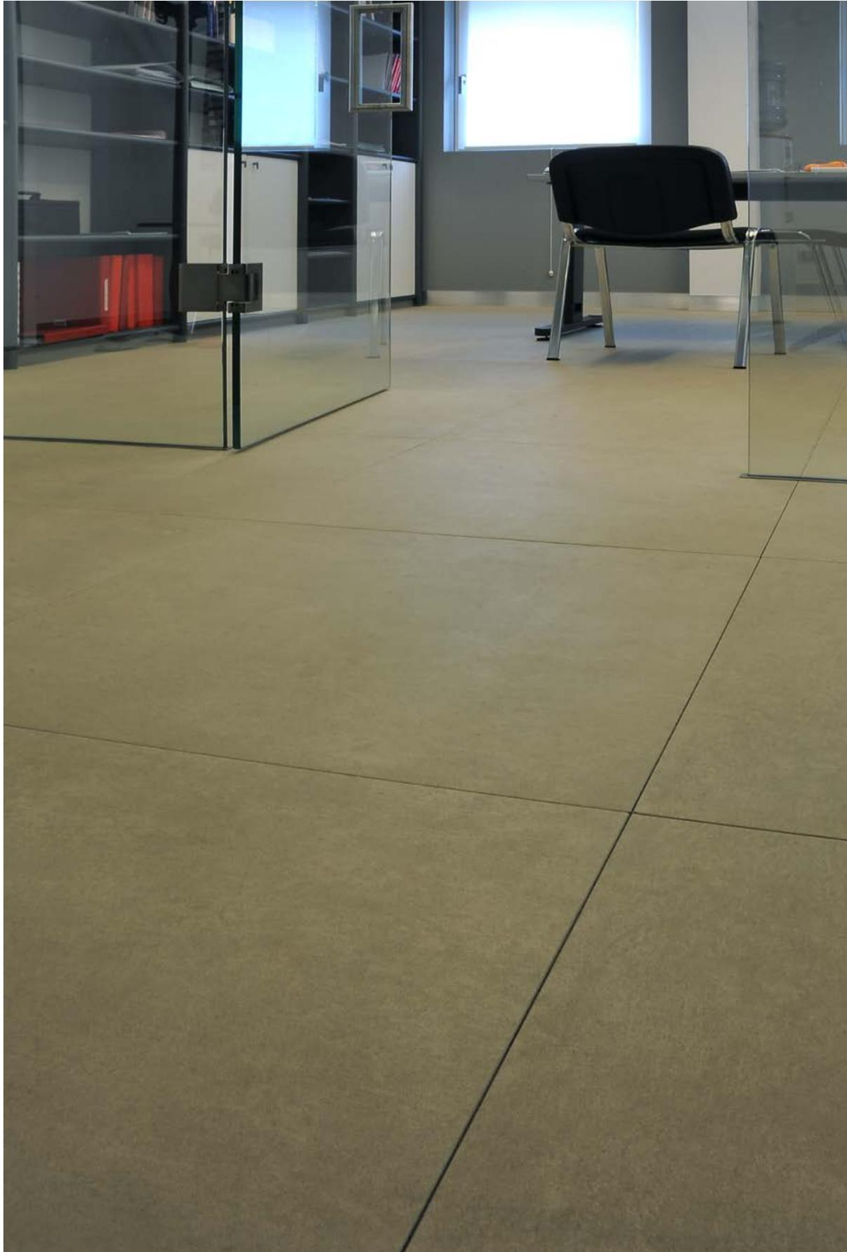
**IT** Ulteriori vantaggi derivanti dall'assemblaggio a secco consistono nella possibilità di posare i materiali in qualsiasi condizione climatica – con notevoli ritorni in particolar modo per i pavimenti sopraelevati in esterno – e di poter calpestare immediatamente le superfici realizzate, non essendo richiesti tempi di attesa per la stabilizzazione delle soluzioni.
